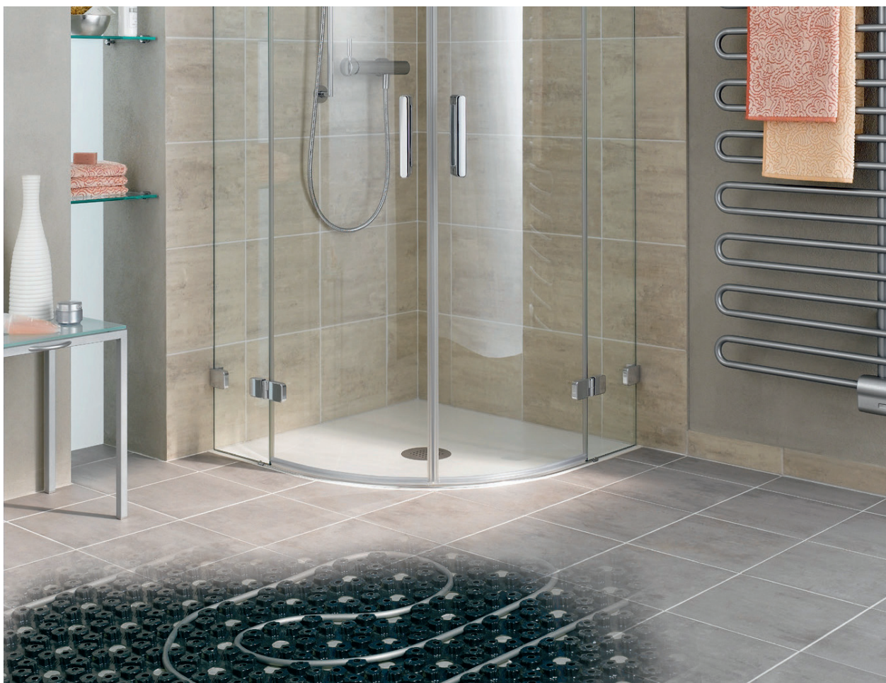
Abb. 24: Fußbodenheizung mit Noppensystem im Badezimmer
