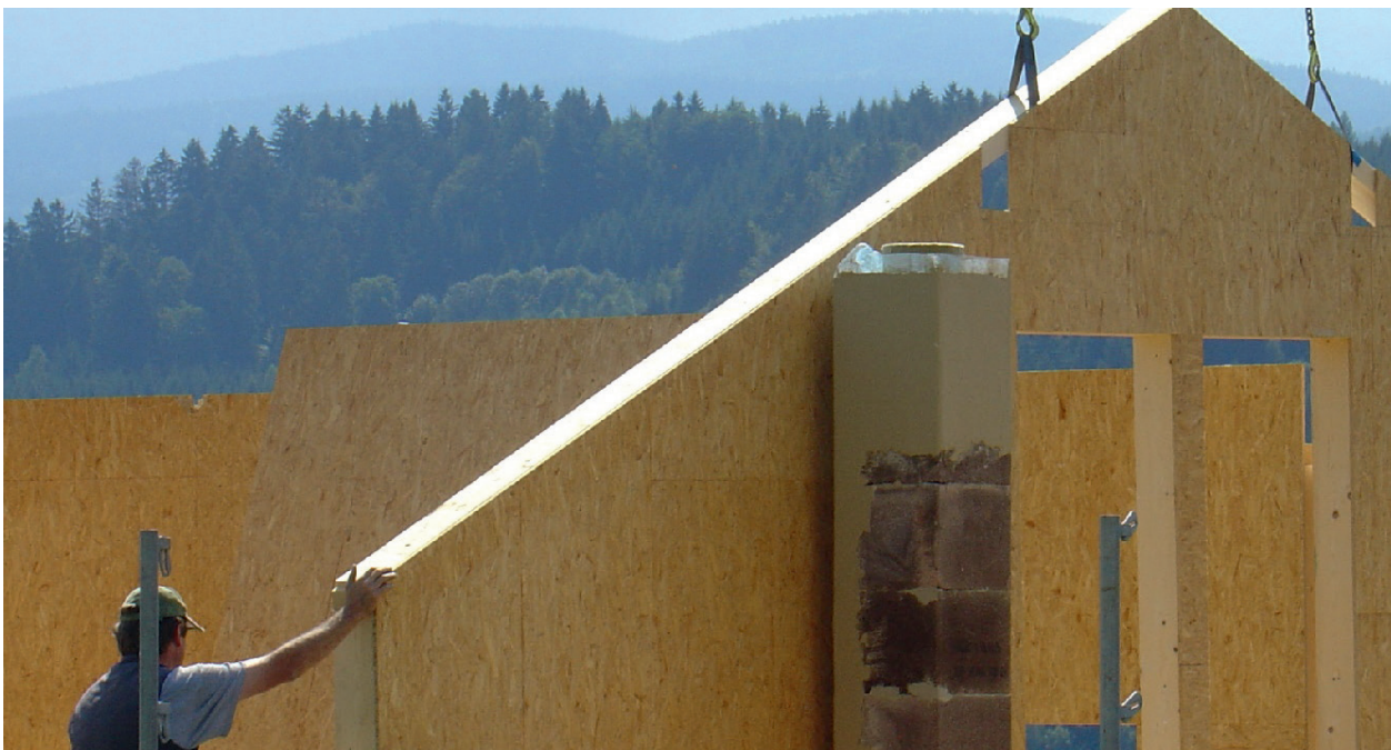
Abb. 10: Aufstellung eines Hauses in Holzrahmenbauweise
