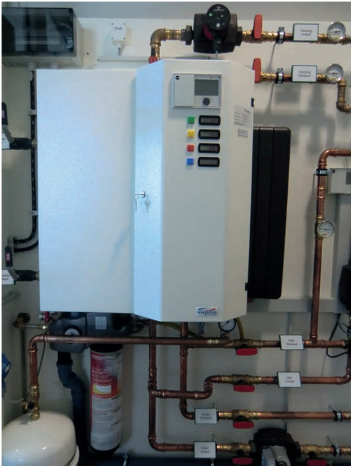
Abb. 18: Einbaubeispiel Wärmeübergabestation.
