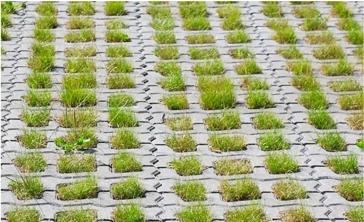
Abb. 8: Rasengittersteine als Alternative zu versiegelten Flächen
