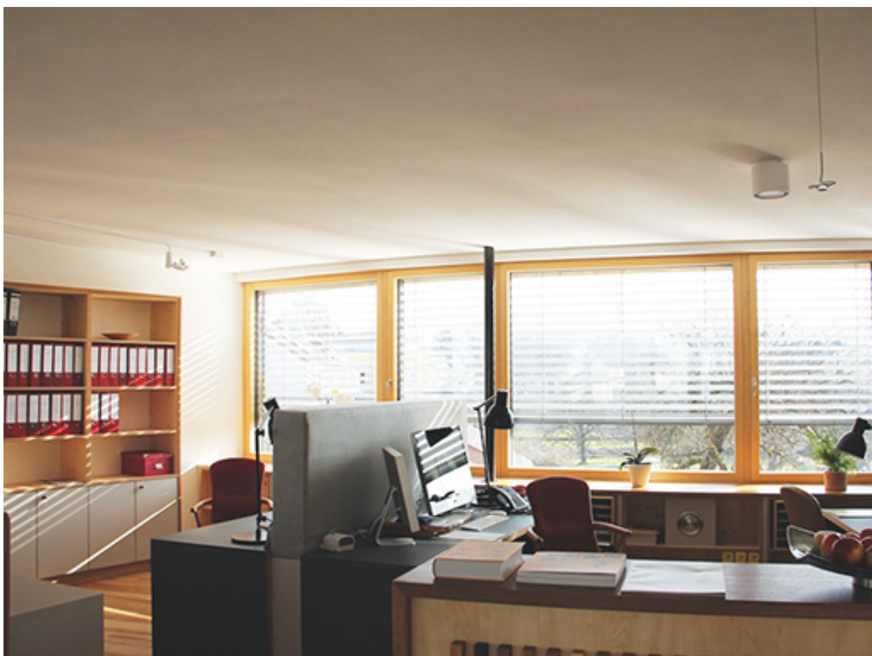
Abb. 6: Lichtumlenkung mit Tageslicht-Raffstores
