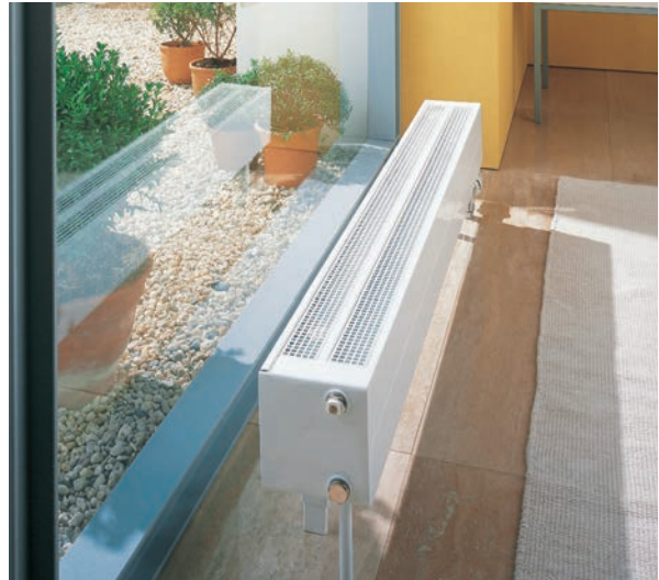
Abb. 23: Langer Heizkörper an breiter Fensterfront
