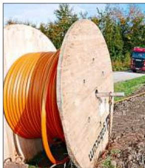
Auf riesigen Holztrommeln sind die Leerrohre aufgewickelt, die im Graben verlegt werden.
